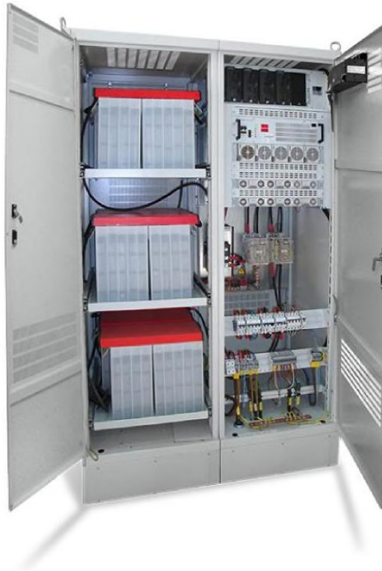
Ilustración 18. Armario de baterías de corriente continua 125 Vcc.
