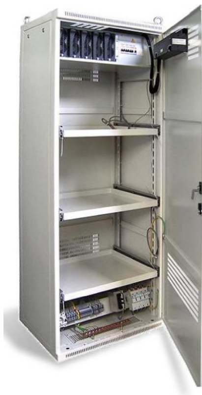
Ilustración 20. Rectificador RAF Argos ubicado en armario.
