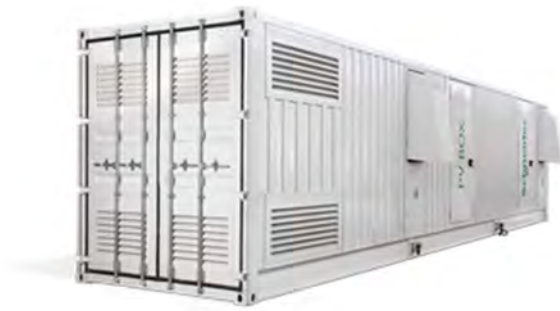
Figura 2: Ejemplo de Centro de transformación
