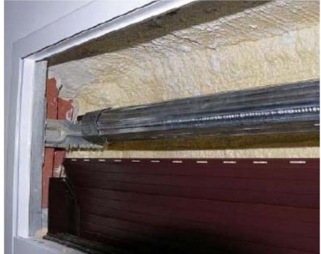
Soluciones no desolidarizadas, falta de tratamiento absorbente, débil aislamiento acústico de la tapa.
