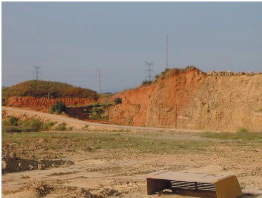
Figura 10.10.: Vista parcial de una de las explotaciones de áridos en el entorno del Cerro de la Pólvara. Se pueden apreciar los taludes provocados por la extracción y la acumulación de desechos. Fuente: Elaboración propia.
