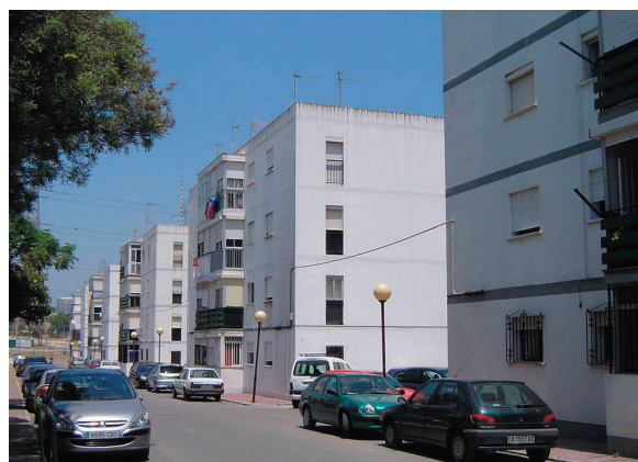
Figura 39: Vista de la Barriada Nazaret en Puente Mayorga, ejemplo de las nuevas edificaciones de varias alturas presentes en el casco urbano. Fuente: Elaboración propia.
