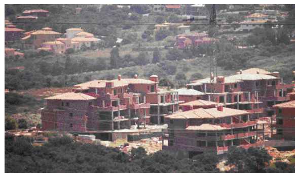
Figura 12: Nuevos edificios en construcción en la parte más interior del valle donde se ha establecido la urbanización de Sotogrande. Fuente: Elaboración propia.
