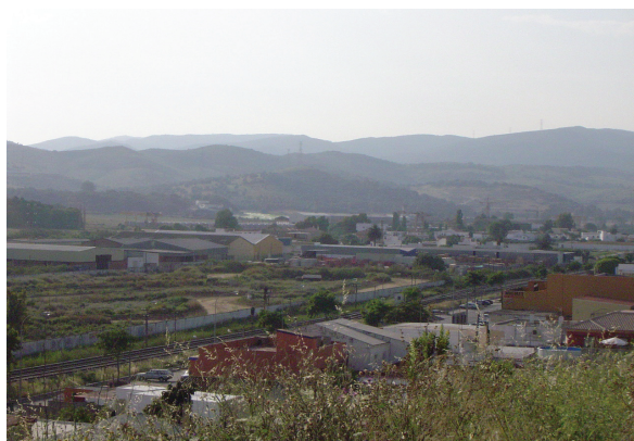
Figura 4: Vista del valle del Guadiaro con la disposición del ferrocarril y las viviendas a lo largo del eje de éste y la carretera hacia Castellar. Fuente: Elaboración propia.
