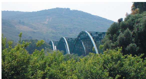
Figura 57: El puente de hierro que cruza el río Guadiaro posee una estructura de tres arcos que
