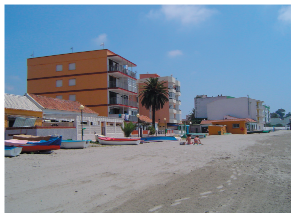
Figura 9: Playa de Puente Mayorga, con edificios de diferentes alturas y tipologías constructivas. Fuente: Elaboración propia.
