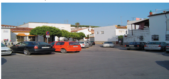
Figura 29: Viviendas unifamiliares de una o dos plantas en el centro de Estación de San Roque, cerca del apeadero del ferrocarril. Fuente: Elaboración propia.
