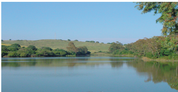
Figura 23: Presa de La Presilla desde la que se abastece a parte de los núcleos de población de la zona occidental de San Roque y regadíos del valle del Guadarranque. Fuente: Elaboración propia.
