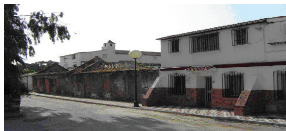
Figura 34: Edificios antiguos de Guadarranque en una de las calles que desembocan directamente al río. Algunas se encuentran en estado ruinoso como se puede apreciar en la imagen. Fuente: Elaboración propia.
