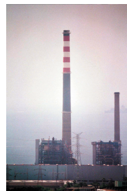
Figura 24: Torres de evacuación de gases de la Central Térmica de Los Barrios. Fuente: Elaboración propia.
