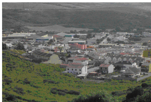
Figura 5: Foto cenital de Estación de San Roque desde la Loma de la Pólvora, en la que se aprecian las diferentes tipologías constructivas. Fuente: Elaboración propia.
