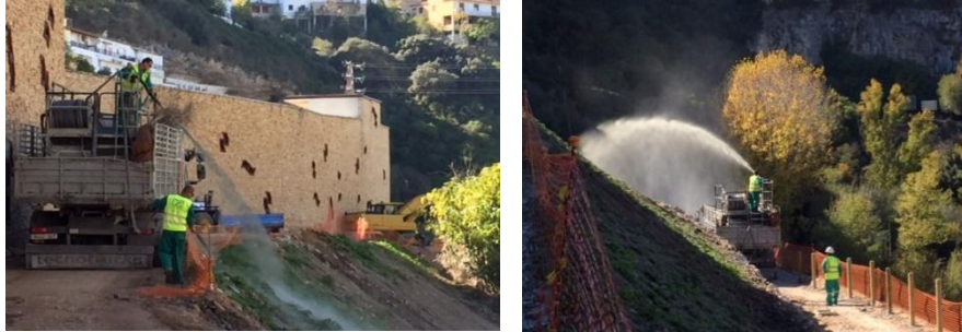
Aplicando la mezcla de semillas en el talud mediante hidrosiembra
