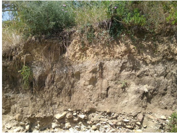
Imagen tomada desde el interior del cauce del arroyo, donde se observa el efecto de los procesos erosivos en los márgenes del mismo
