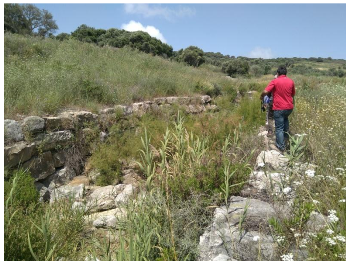
Encauzamiento de la cabecera del arroyo de la Morra realizado con mampostería.
