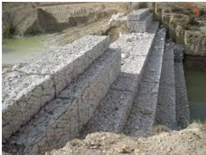
Ejemplo de vertedero escalonado entre lago y cauce
