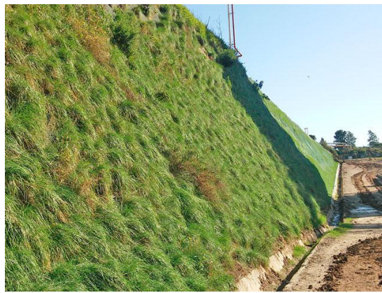
Aspecto final de un talud tratado con hidrosiembra
