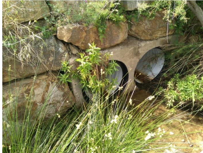
Inicio de los tubos que dan origen al arroyo de la Morra sobre la superficie de actuación.
