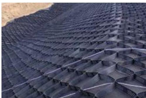
Detalle de las geoceldas a instalar
